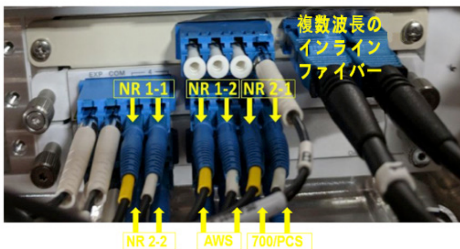
図11.1つのファイバーに複数の波長があり、さまざまな無線機に向かう多くの波長に分解するファイバー
